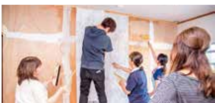
▲入居者が選んだクロスを自ら施工
